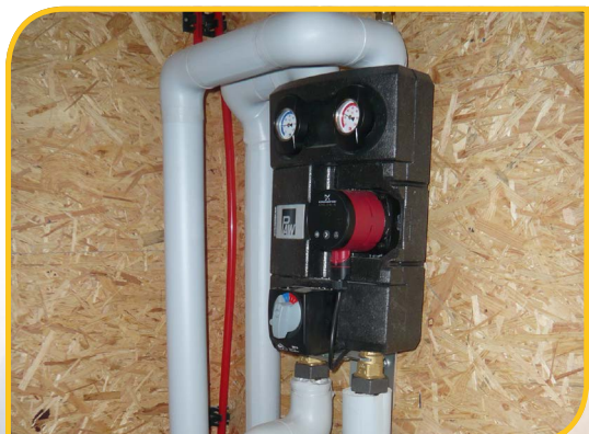
Isolation renforcée des conduites
