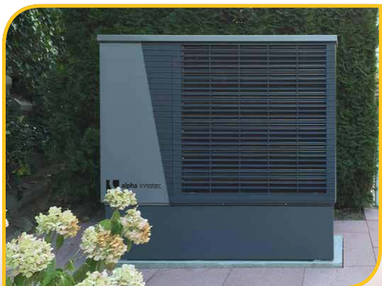
Montage au sol
